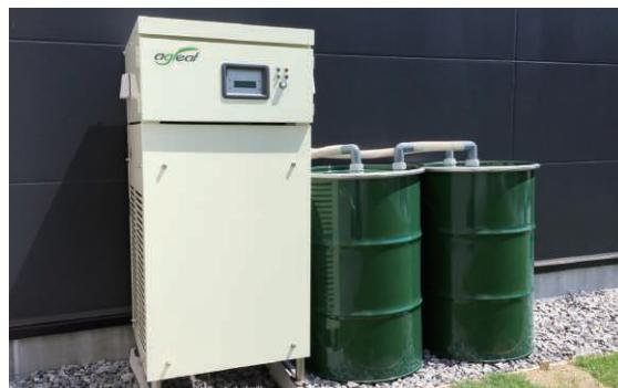
ハウス栽培用CO<sub>2</sub>貯留・供給装置
